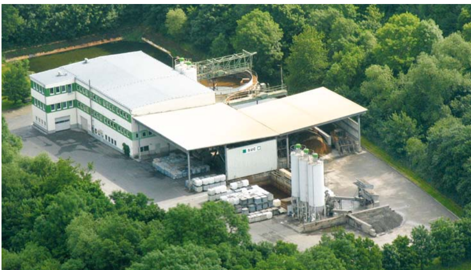
Luftaufnahme des Standortes Ohrdruf der SUC Entsorgung GmbH
